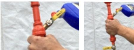
Incorporer 50 mL de traitement ALD -3 dans la réserve de l'Inject-Air et fermer la valve. Voir la charte de dosage recommandé à la page 2.
